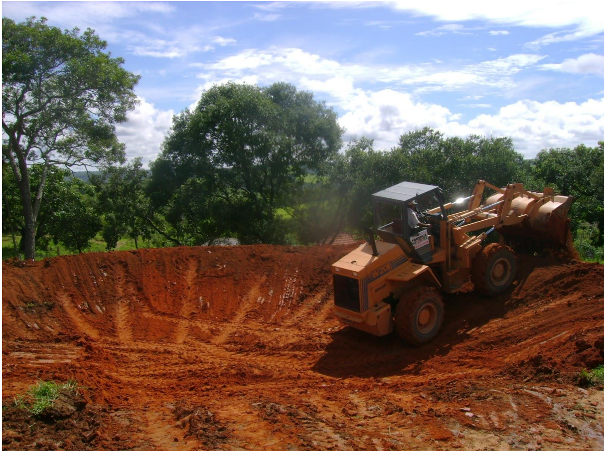
Figura 11: Pá-carregadeira durante a construção de uma bacia de captação
