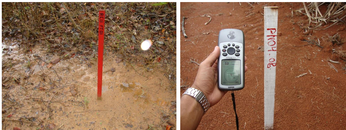
Figura 8: Exemplos de estaqueamentos provenientes de locação topográfica de projetos hidroambientais
